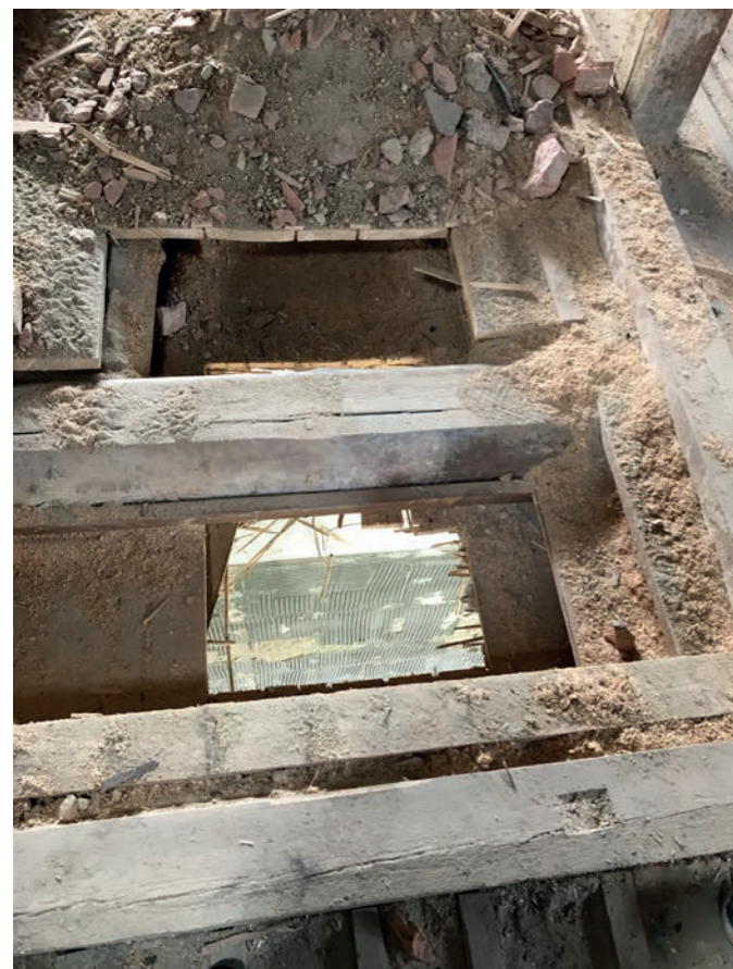
Obr. 6 – Odkryté trámy dřevěného stropu
