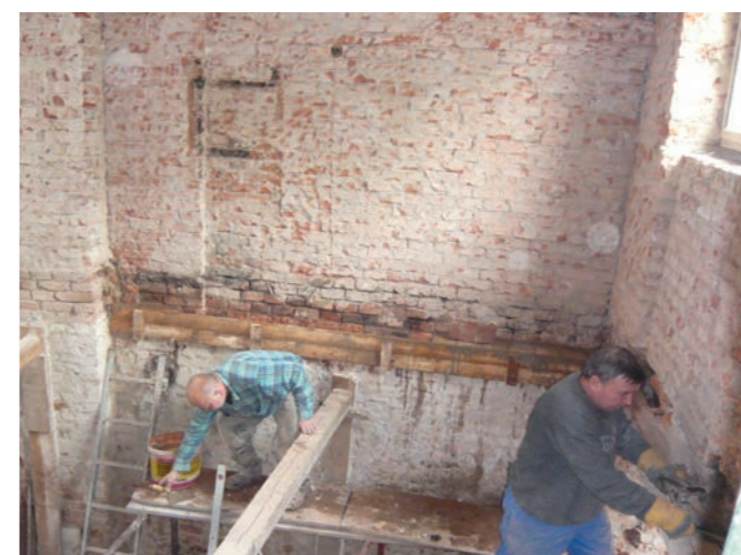
Obr. 2 – Výškové dorovnání ustupující stěny
