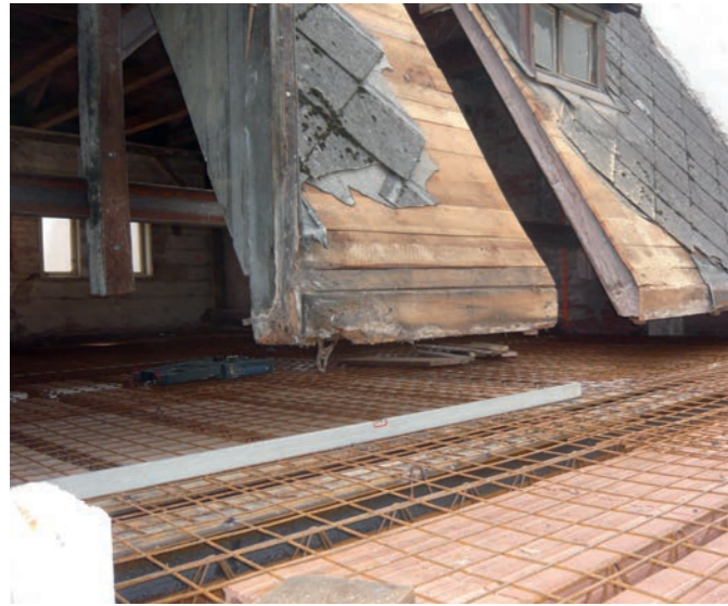
Obr. 20a – Realizace stropu v komplikovaných podmínkách
