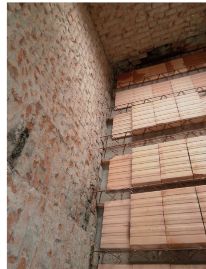
Obr. 3 – Uložené trámy a vložky na vyrovnané ustupující zdivo
