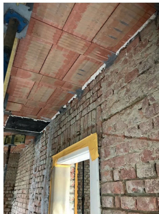
Obr. 10 – Stropní POT trámy doplněné vložkami MIAKO
