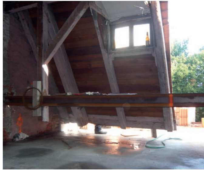
Obr. 20b – Realizace stropu v komplikovaných podmínkách
