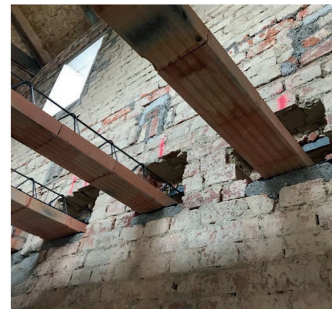
Obr. 9 – Spodní pohled na uložené POT trámy
