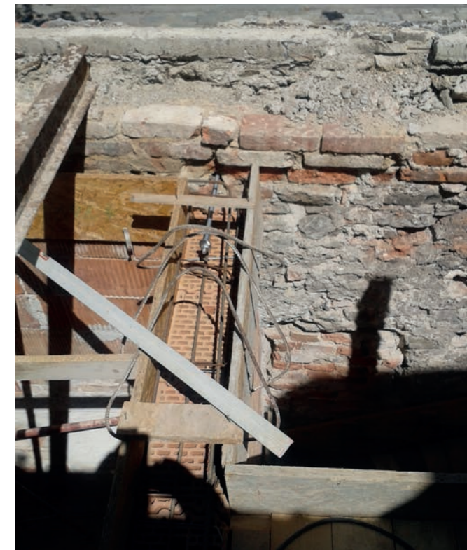
Obr. 19 – Kotvení obvodového zdiva na nové vnitřní nosné stěny
