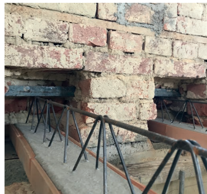
Obr. 8 – Uložení POT trámů do kapes s vyrovnávací podbetonávkou
