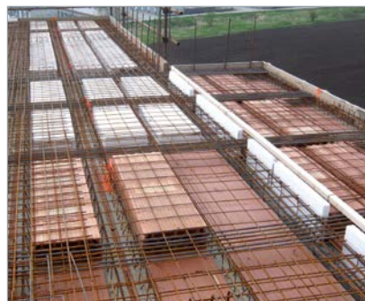
přerušení tepelného mostu mezi balkónem a stropem
