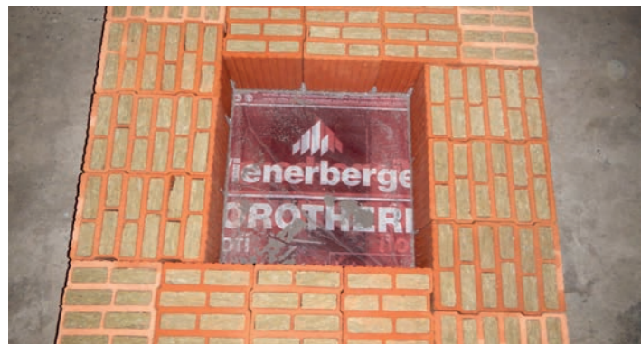
Obr. 7 Imitace první řady cihel
