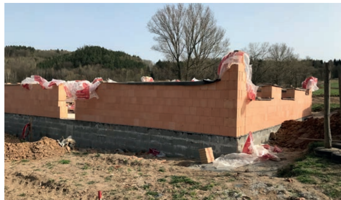
Obr. 42 – Zakrývá se pomocí asfaltových papírových lepenek či igelitů, nesmí se zapomínat i na sloupky a parapety
