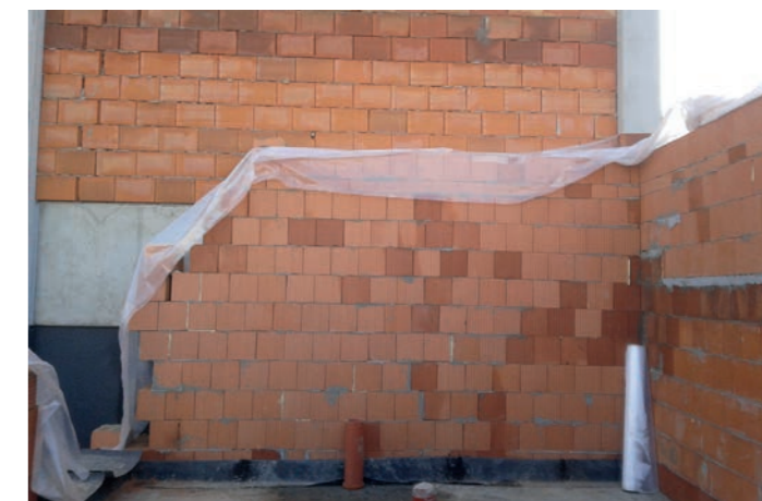
Obr. 44 – Použité mokré cihly ve stavbě jsou snadno identifikovatelné
