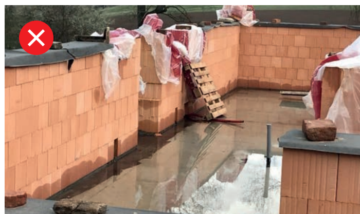
Obr. 40 – Při nepoužití soklových cihel dojde při dešti k nasáknutí první vrstvy zdiva vodou nahromaděnou na základové desce
