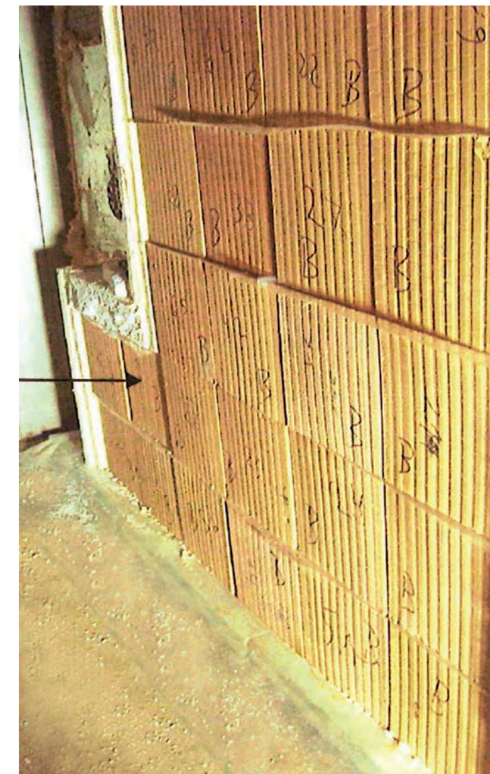
Obr. 37 Na sucho vyskládaná stěna
