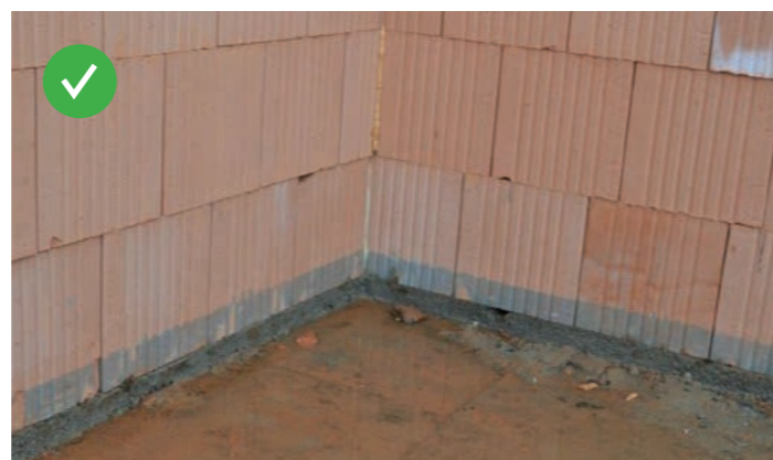
Obr. 41 – Použití soklových cihel zabrání nasáknutí keramiky první vrstvy cihel
