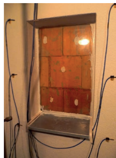
Obr. 33 Zatmělení skla a parapetu
