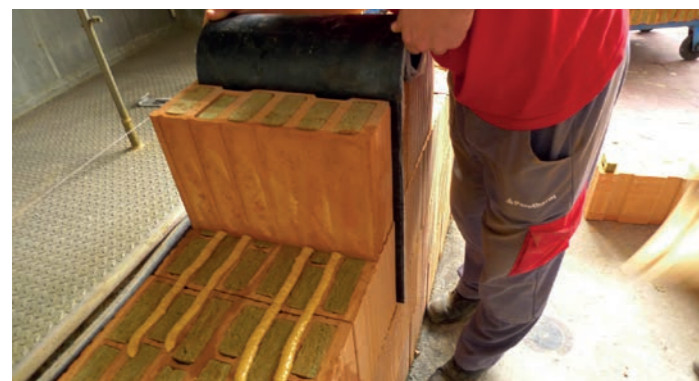
Obr. 27 a 28 Fragment rozdělený na dvě poloviny svisle oddělené hydroizolací (na omítnutou a neomítnutou část)
