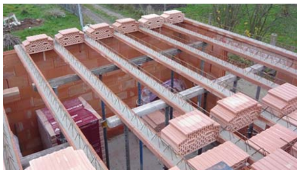
Kladení vložek na předem podepřené trámy
