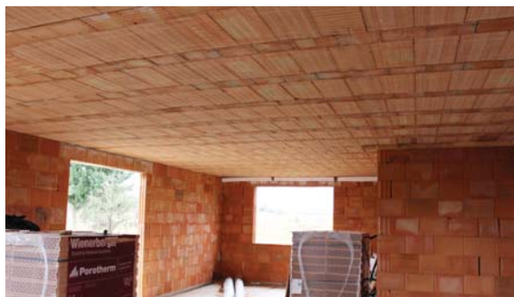
Strop po zabetonování
