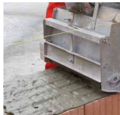
nanášení maltovacím vozíkem na celou plochu ložné spáry
